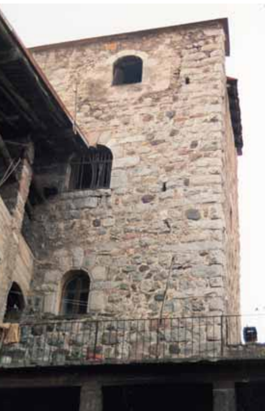
Facciata rivolta a nord: sono visibili le finestre del 2°, 3° ed ultimo piano
