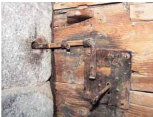
Particolare del catenaccio esterno al portoncino
