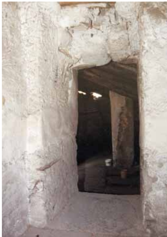
L'accesso al secondo piano della torre è stato ricavato da una finestra che si apriva sul lato est
