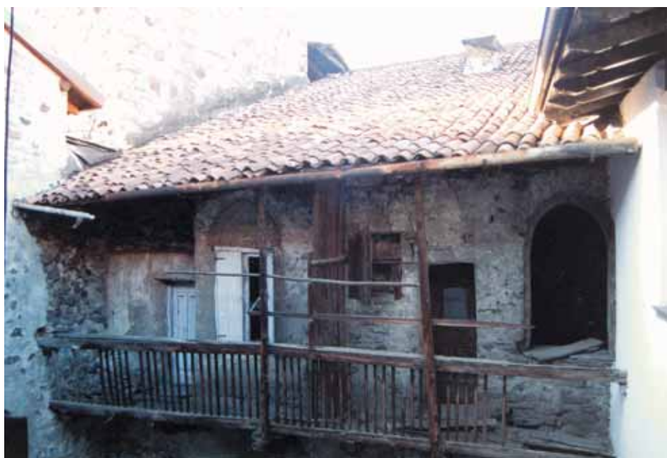
Vecchia abitazione che metteva in collegamento la torre con casa Ronchi
