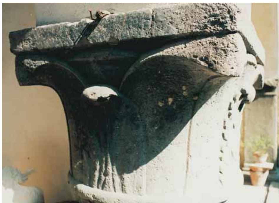
Particolare del capitello delle colonne
