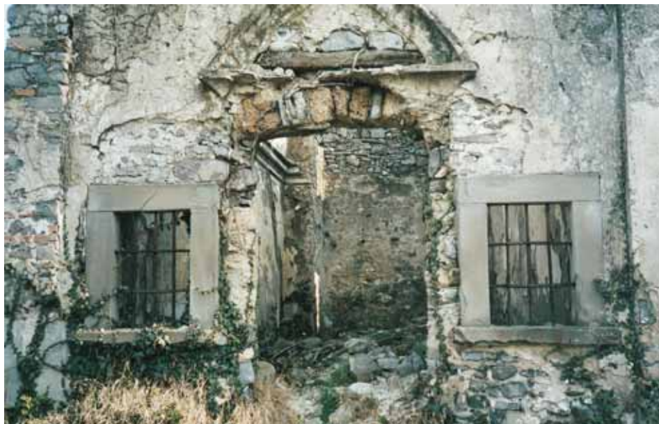
Chiesa di S. Michele, particolare dell'ingresso
