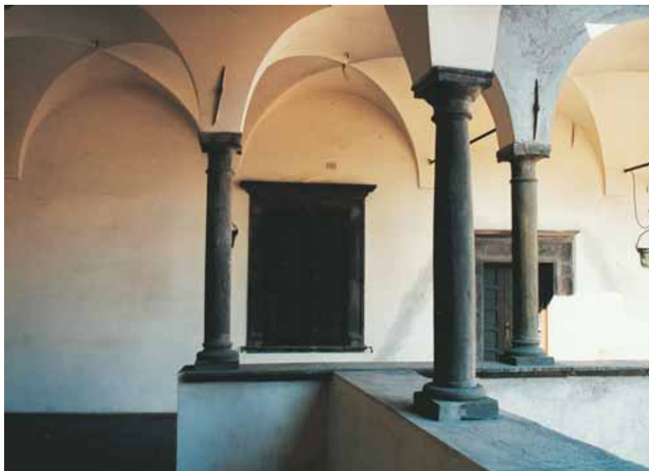
Loggiato: particolare delle volte
